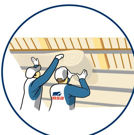
Aplikace minerální izolace URSA PUREONE DF 39 do příčného kovového roštu upevněného na krovky, jako druhá tepelně izolační vrstva. Izolaci vkládáme lehkým vtlačením po celé délce roštu. Dbejte stejných zásad jako v předešlém aplikačním kroku.
