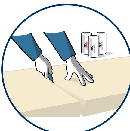
Odřízneme naměřenou část minerální izolace URSA PUREONE DF 39. Řez provádime podél přitlačné lišty (část OSB desky, kovový profil apod.) speciálním nožem URSA určeným k rezání izolace.
